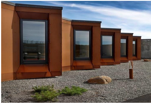
Hólmshéiði - Cellules aux fenêtres extrudées (Photo : Hreinn Magnússon©)
